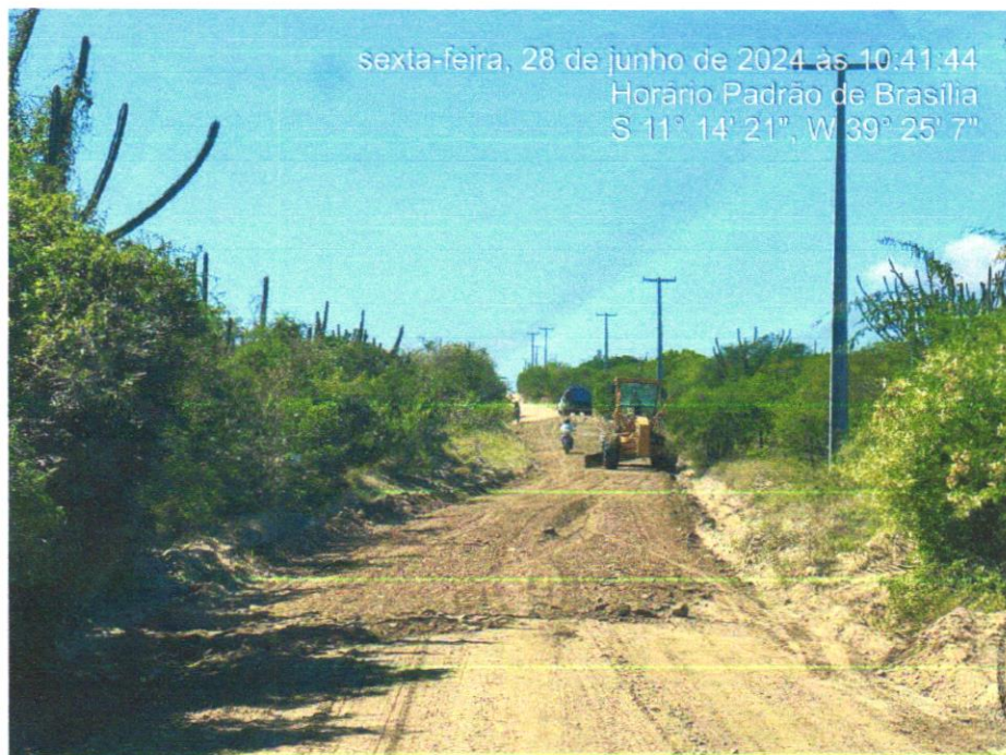
Foto 08 - EXECUÇÃO E COMPACTAÇÃO DE ATERRO COM SOLO PREDOMINANTEMENTE ARGILOSO - EXCLUSIVE SOLO, ESCAVAÇÃO, CARGA E TRANSPORTE. AF_11/2019
