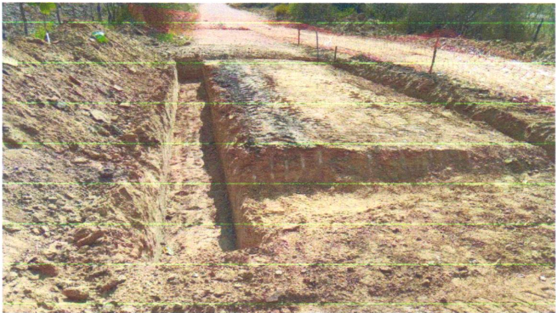
Foto 10 - ESCAVAÇÃO MANUAL DE VALA COM PROFUNDIDADE MENOR OU IGUAL A 1,30 M. AF_02/2021
